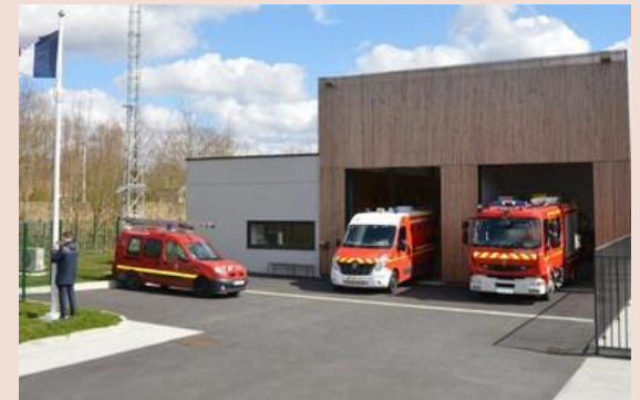
Centre de secours
