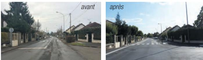
**Les réseaux filaires aériens et les différents poteaux ont disparus, les candélabres avec une nouvelle technologie assurent un éclairage maîtrisé et les riverains sont raccordés par des réseaux neufs.**
