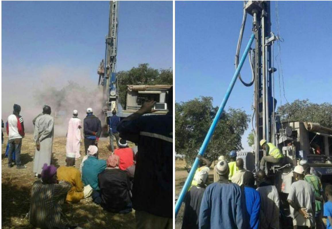
Les villageois ont assisté aux opérations de forage et à la descente des tubes dans le puits de forage
